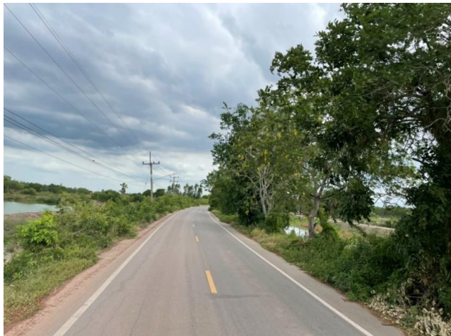
รูปก่อนการก่อสร้าง กม.ที่ ๙+๖๐๐
