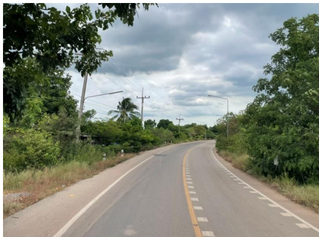
รูปก่อนการก่อสร้าง กม.ที่ ๑๒+๕๐๐
