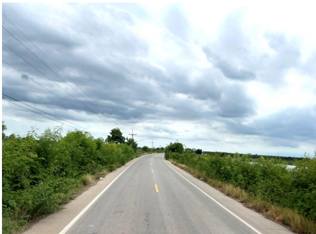
รูปก่อนการก่อสร้าง กม.ที่ ๙+๓๐๐
