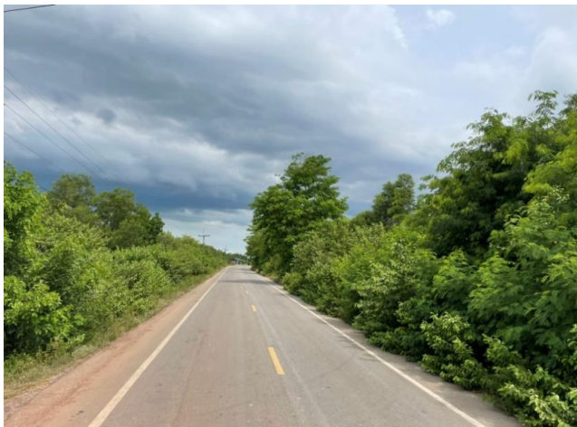
รูปก่อนการก่อสร้าง กม.ที่ ๘+๕๐๐
