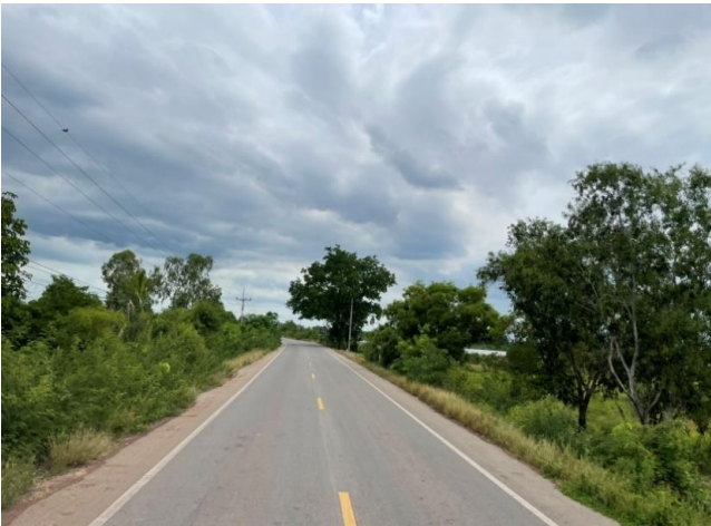
รูปก่อนการก่อสร้าง กม.ที่ ๙+๑๐๐
