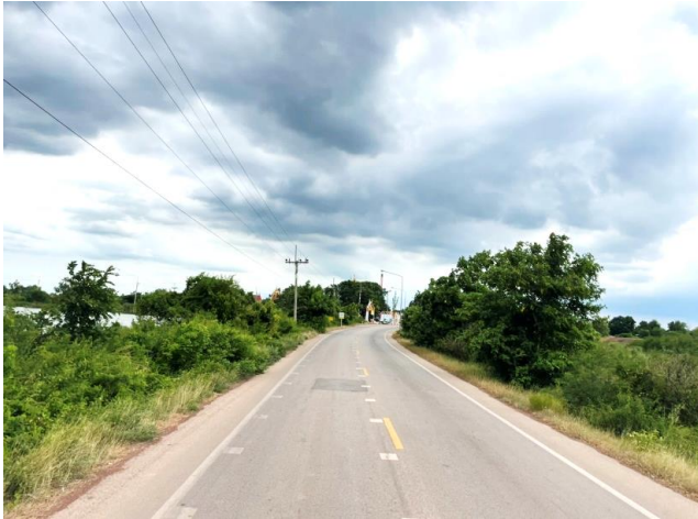
รูปก่อนการก่อสร้าง กม.ที่ ๑๒+๐๐๐
