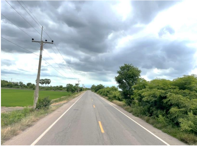
รูปก่อนการก่อสร้าง กม.ที่ ๑๑+๔๐๐
