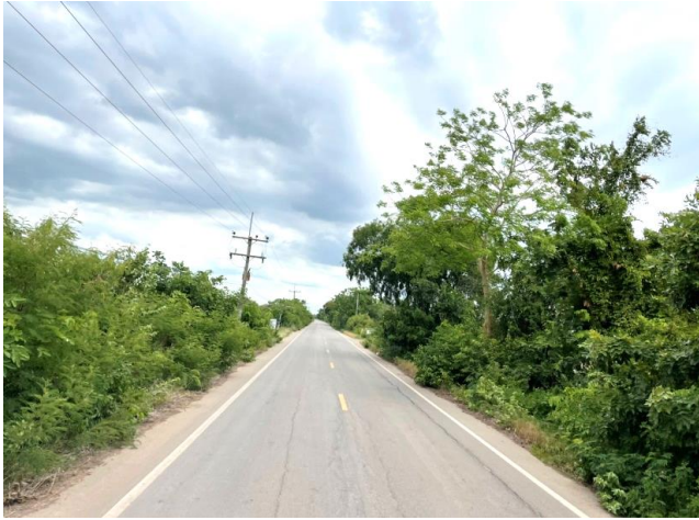
รูปก่อนการก่อสร้าง กม.ที่ ๑๐+๒๐๐
