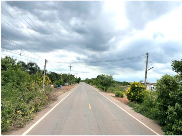
รูปก่อนการก่อสร้าง กม.ที่ ๑๑+๐๐๐
