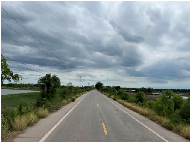
รูปก่อนการก่อสร้าง กม.ที่ ๙+๔๐๐
