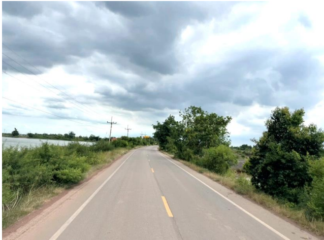
รูปก่อนการก่อสร้าง กม.ที่ ๑๑+๘๐๐
