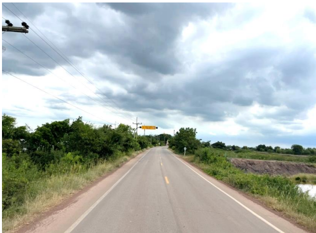
รูปก่อนการก่อสร้าง กม.ที่ ๑๑+๙๐๐
