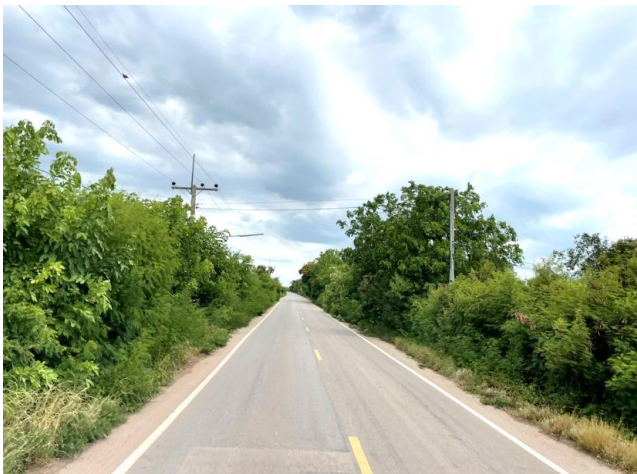
รูปก่อนการก่อสร้าง กม.ที่ ๑๐+๓๐๐
