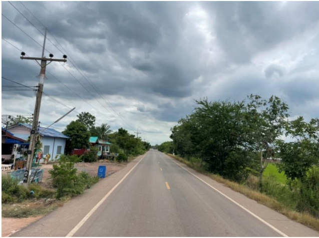
รูปก่อนการก่อสร้าง กม.ที่ ๑๐+๘๐๐
