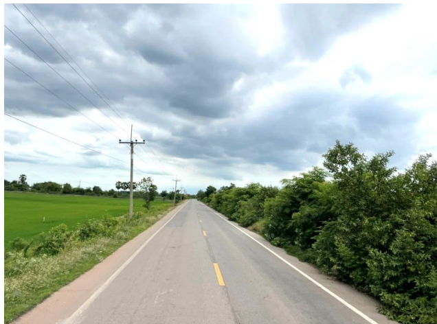
รูปก่อนการก่อสร้าง กม.ที่ ๑๑+๓๐๐
