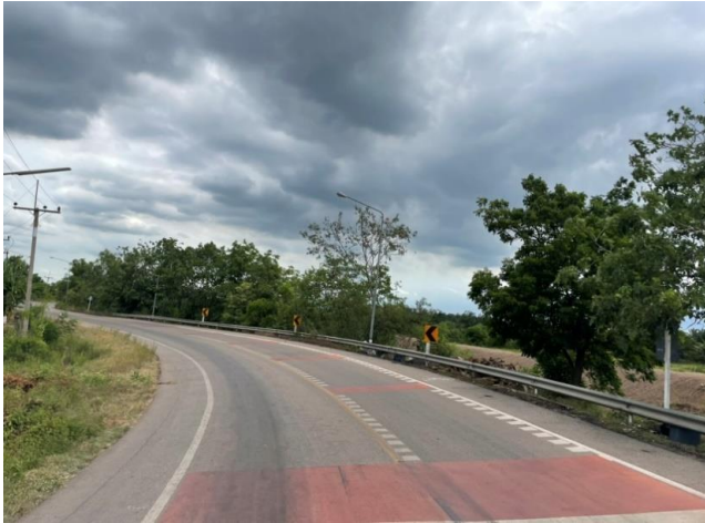
รูปก่อนการก่อสร้าง กม.ที่ ๑๒+๔๐๐
