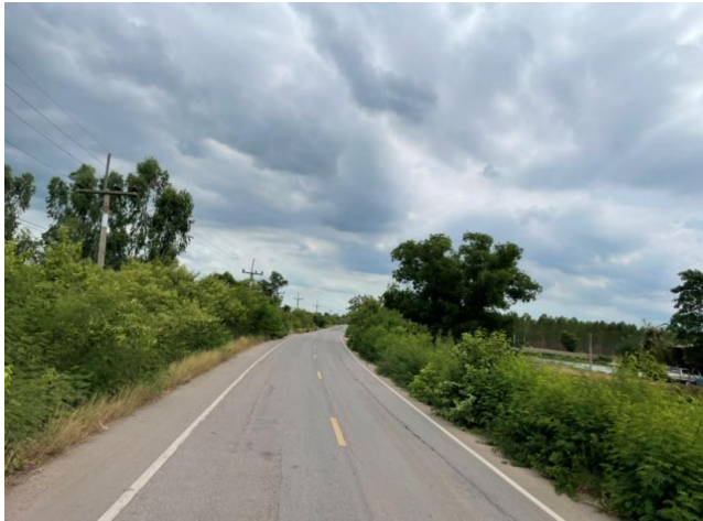
รูปก่อนการก่อสร้าง กม.ที่ ๙+๘๐๐
