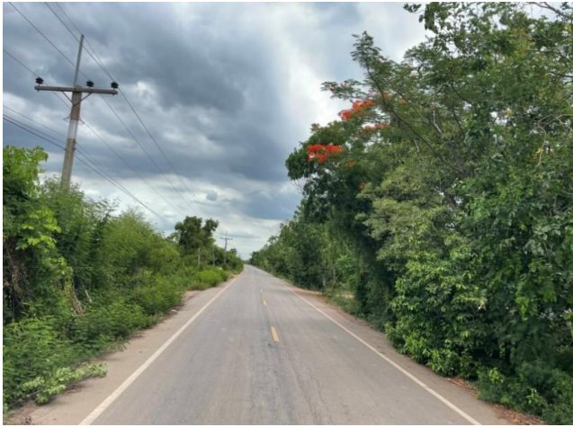
รูปก่อนการก่อสร้าง กม.ที่ ๑๐+๔๐๐
