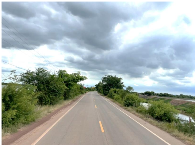
รูปก่อนการก่อสร้าง กม.ที่ ๑๑+๗๐๐
