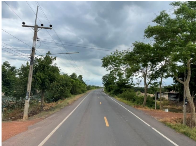
รูปก่อนการก่อสร้าง กม.ที่ ๑๓+๒๐๐
