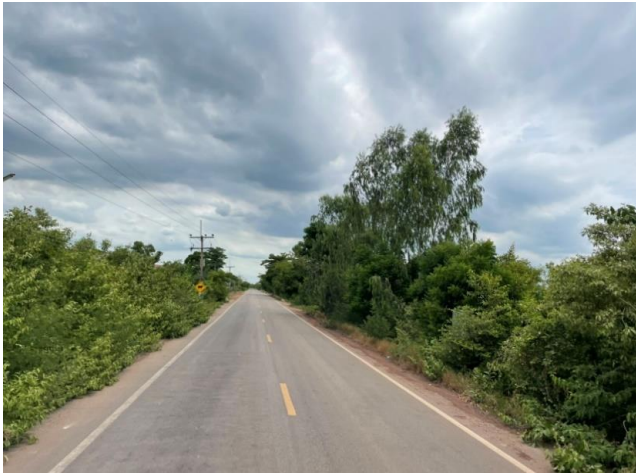
รูปก่อนการก่อสร้าง กม.ที่ ๑๐+๖๐๐
