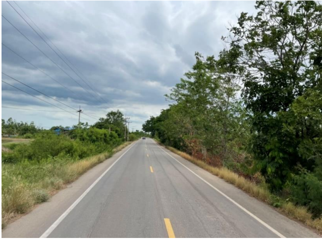
รูปก่อนการก่อสร้าง กม.ที่ ๙+๐๐๐
