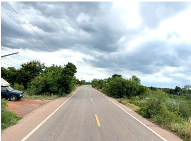
รูปก่อนการก่อสร้าง กม.ที่ ๑๑+๑๐๐
