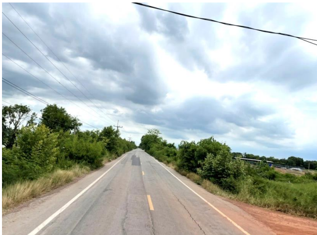
รูปก่อนการก่อสร้าง กม.ที่ ๑๐+๑๐๐
