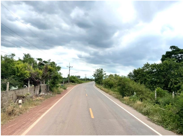
รูปก่อนการก่อสร้าง กม.ที่ ๑๑+๒๐๐
