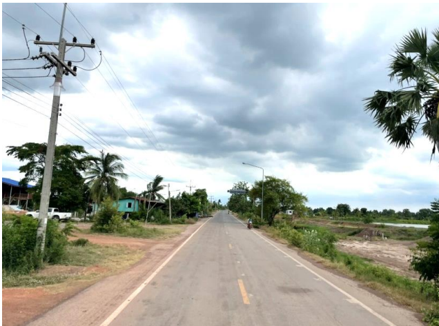
รูปก่อนการก่อสร้าง กม.ที่ ๑๒+๗๐๐
