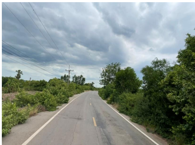
รูปก่อนการก่อสร้าง กม.ที่ ๙+๗๐๐
