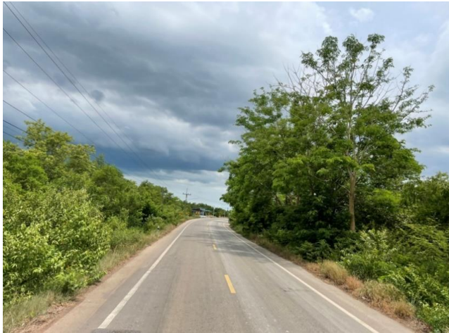
รูปก่อนการก่อสร้าง กม.ที่ ๘+๖๐๐
