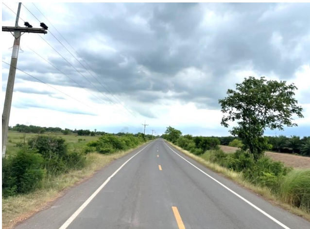
รูปก่อนการก่อสร้าง กม.ที่ ๑๓+๓๐๐
