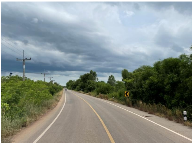
รูปก่อนการก่อสร้าง กม.ที่ ๘+๓๐๐
