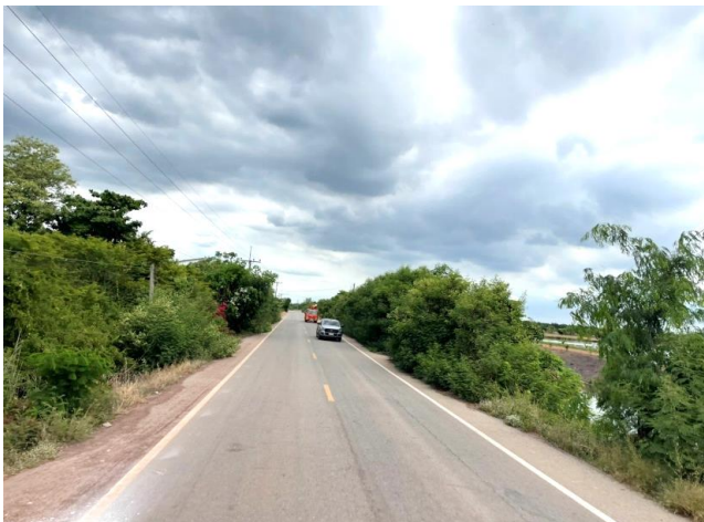
รูปก่อนการก่อสร้าง กม.ที่ ๑๐+๙๐๐
