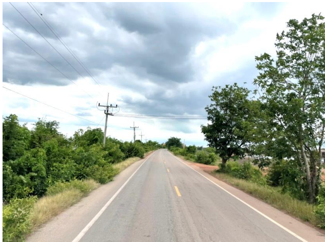
รูปก่อนการก่อสร้าง กม.ที่ ๑๑+๖๐๐
