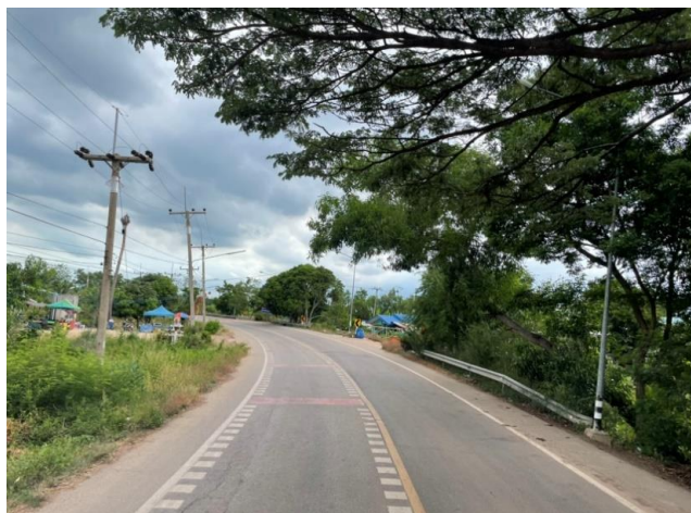
รูปก่อนการก่อสร้าง กม.ที่ ๑๒+๓๐๐
