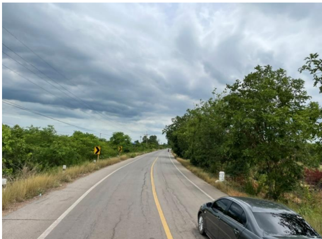
รูปก่อนการก่อสร้าง กม.ที่ ๘+๙๐๐
