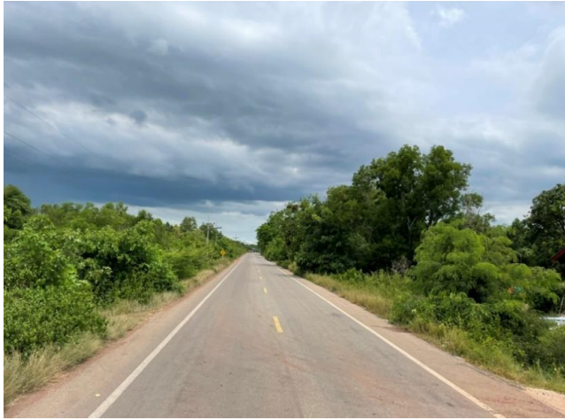
รูปก่อนการก่อสร้าง กม.ที่ ๘+๔๐๐
