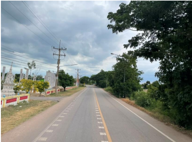
รูปก่อนการก่อสร้าง กม.ที่ ๑๒+๒๐๐
