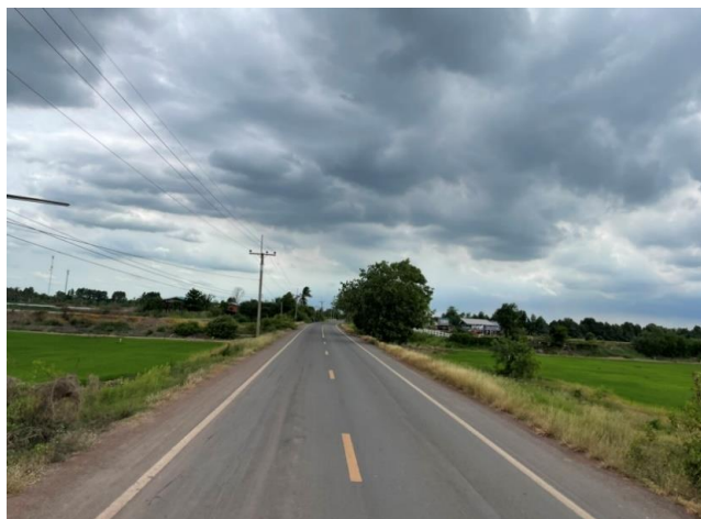
รูปก่อนการก่อสร้าง กม.ที่ ๑๒+๙๐๐
