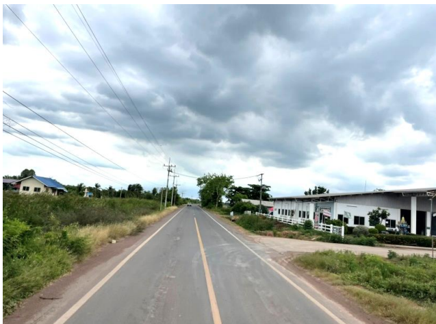
รูปก่อนการก่อสร้าง กม.ที่ ๑๓+๑๐๐
