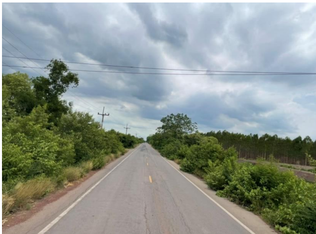
รูปก่อนการก่อสร้าง กม.ที่ ๙+๙๐๐
