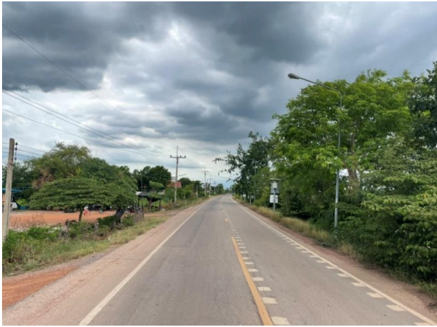
รูปก่อนการก่อสร้าง กม.ที่ ๑๒+๖๐๐
