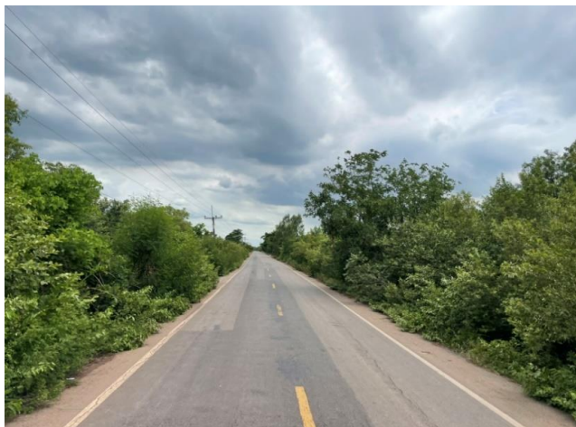
รูปก่อนการก่อสร้าง กม.ที่ ๑๐+๕๐๐
