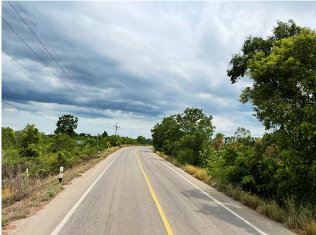
รูปก่อนการก่อสร้าง กม.ที่ ๘+๘๐๐
