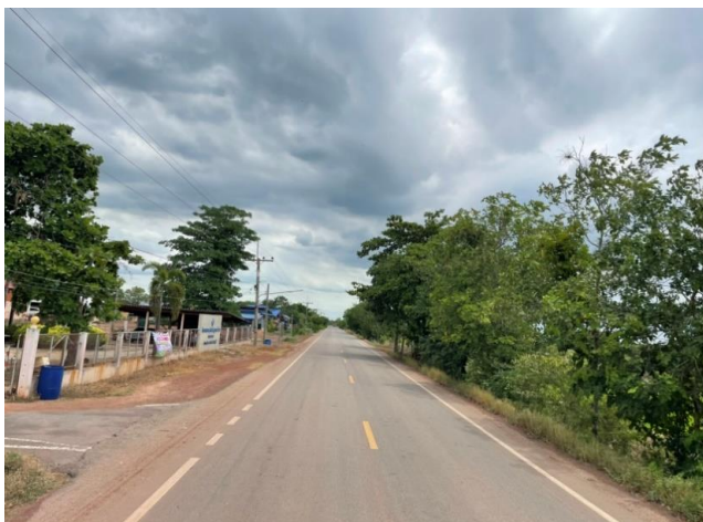
รูปก่อนการก่อสร้าง กม.ที่ ๑๐+๗๐๐
