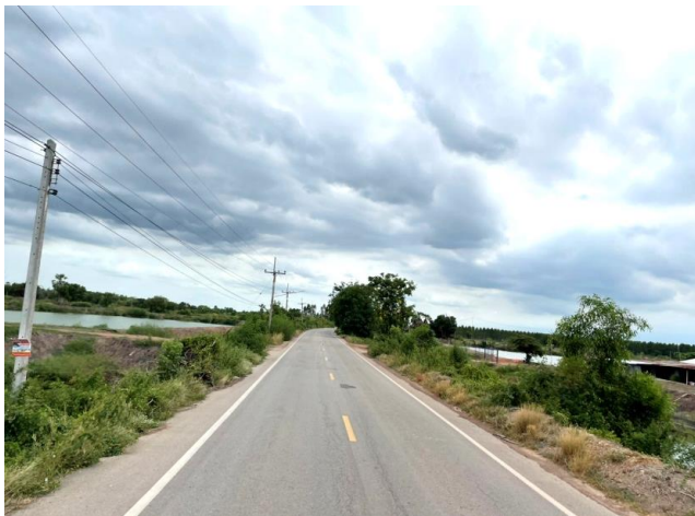
รูปก่อนการก่อสร้าง กม.ที่ ๙+๕๐๐
