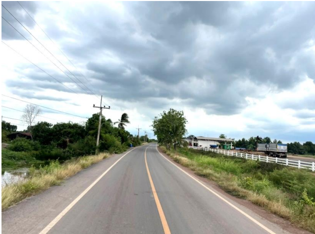
รูปก่อนการก่อสร้าง กม.ที่ ๑๓+๐๐๐
