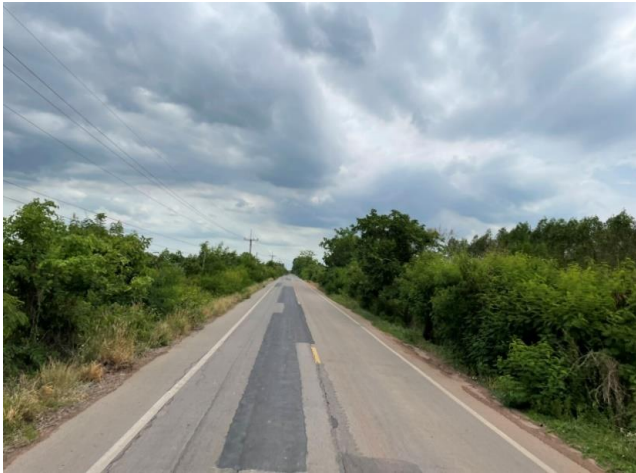
รูปก่อนการก่อสร้าง กม.ที่ ๑๐+๐๐๐
