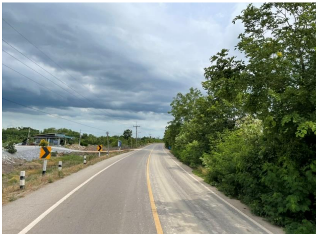
รูปก่อนการก่อสร้าง กม.ที่ ๘+๗๐๐
