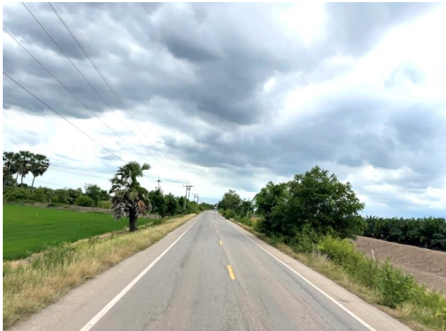
รูปก่อนการก่อสร้าง กม.ที่ ๑๑+๕๐๐
