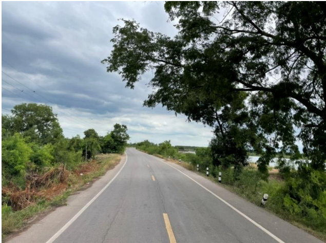
รูปก่อนการก่อสร้าง กม.ที่ ๙+๒๐๐
