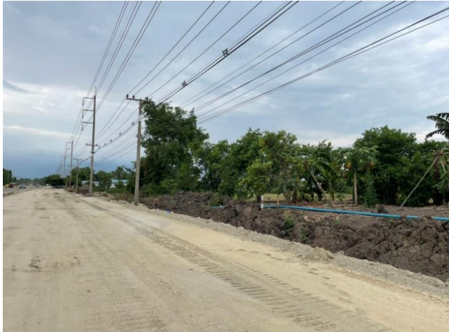
รูปก่อนการก่อสร้าง กม.ที่ ๒๔+๘๐๐
