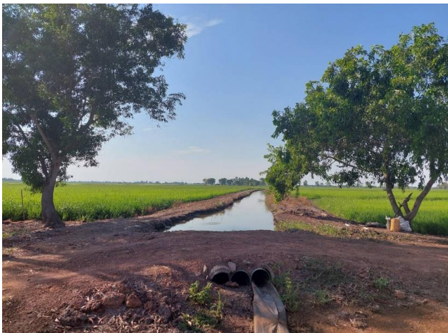
รูปก่อนการก่อสร้าง กม.ที่ ๒๐+๕๐๐
