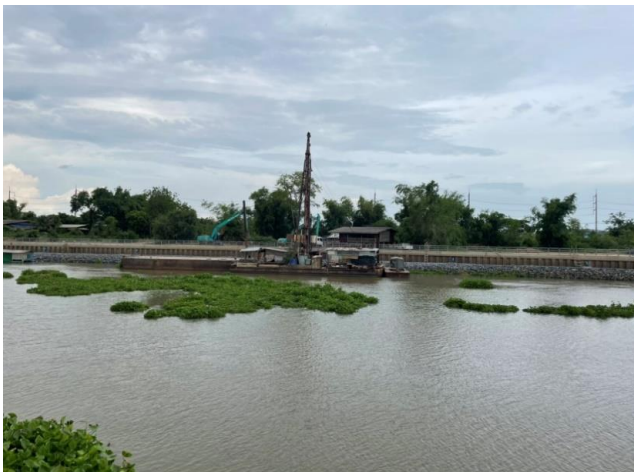
รูปก่อนการก่อสร้าง กม.ที่ ๒๕+๕๐๐
