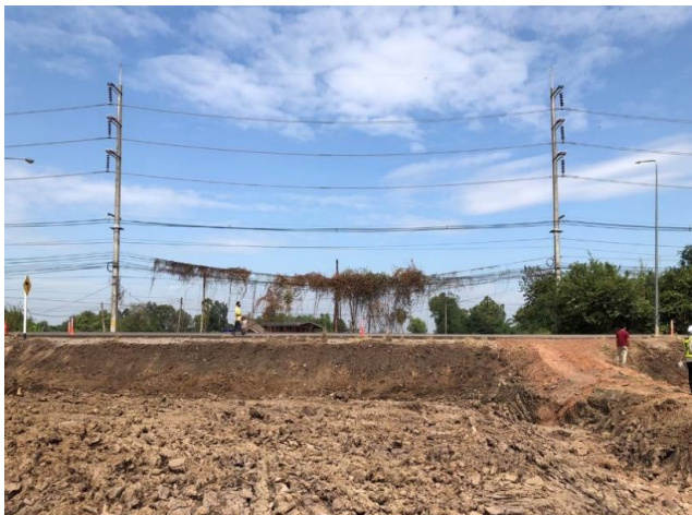
รูปก่อนการก่อสร้าง กม.ที่ ๒๕+๓๐๐
