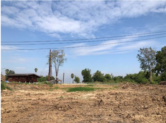
รูปก่อนการก่อสร้าง กม.ที่ ๒๕+๔๐๐
