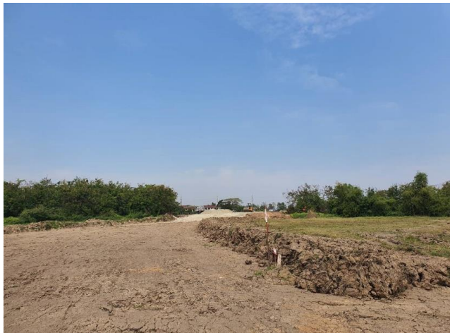
รูปก่อนการก่อสร้าง กม.ที่ ๒๕+๐๐๐
