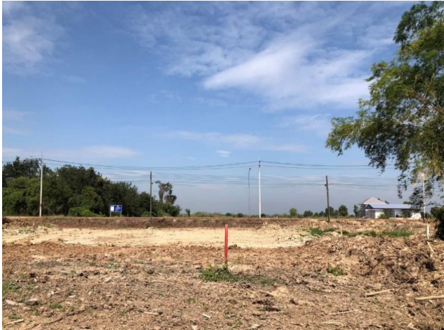
รูปก่อนการก่อสร้าง กม.ที่ ๒๕+๖๐๐
