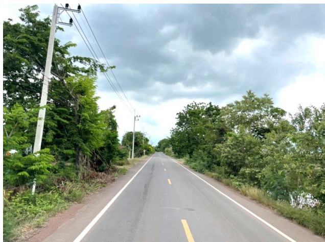
รูปก่อนการก่อสร้าง กม.ที่ ๑๔+๕๐๐
