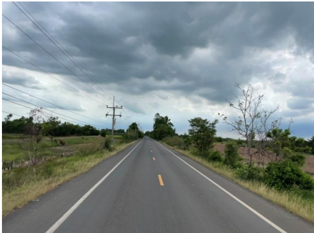
รูปก่อนการก่อสร้าง กม.ที่ ๑๔+๐๐๐
