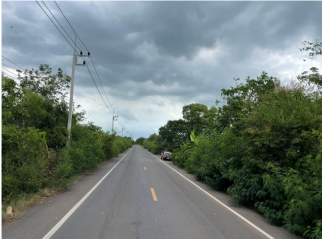
รูปก่อนการก่อสร้าง กม.ที่ ๑๔+๒๐๐
