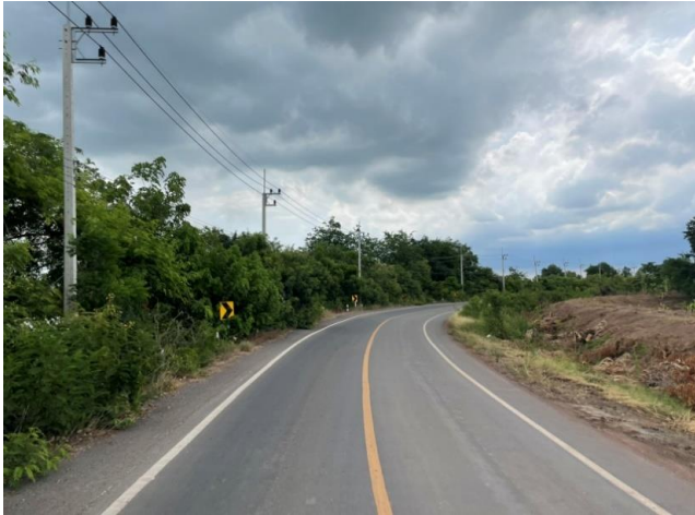
รูปก่อนการก่อสร้าง กม.ที่ ๑๔+๘๐๐
