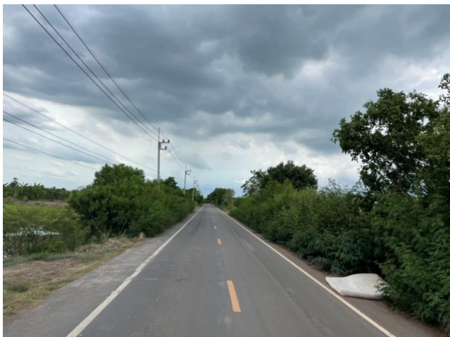
รูปก่อนการก่อสร้าง กม.ที่ ๑๔+๓๐๐
