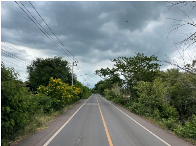
รูปก่อนการก่อสร้าง กม.ที่ ๑๔+๖๐๐
