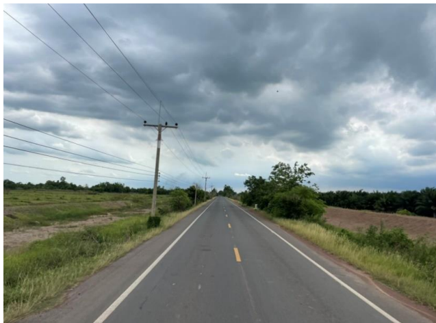
รูปก่อนการก่อสร้าง กม.ที่ ๑๓+๗๐๐
