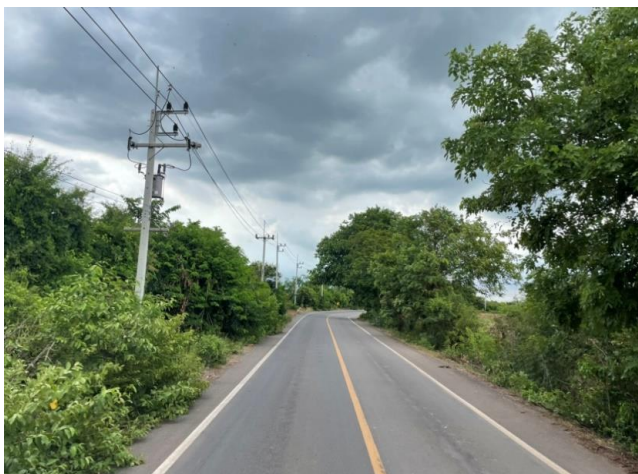
รูปก่อนการก่อสร้าง กม.ที่ ๑๔+๗๐๐
