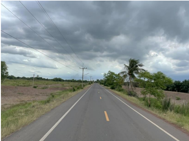
รูปก่อนการก่อสร้าง กม.ที่ ๑๓+๖๐๐
