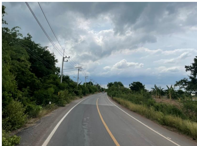
รูปก่อนการก่อสร้าง กม.ที่ ๑๔+๙๐๐
