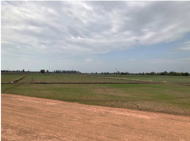
รูปก่อนการก่อสร้าง กม.ที่ ๑๙+๔๐๐
