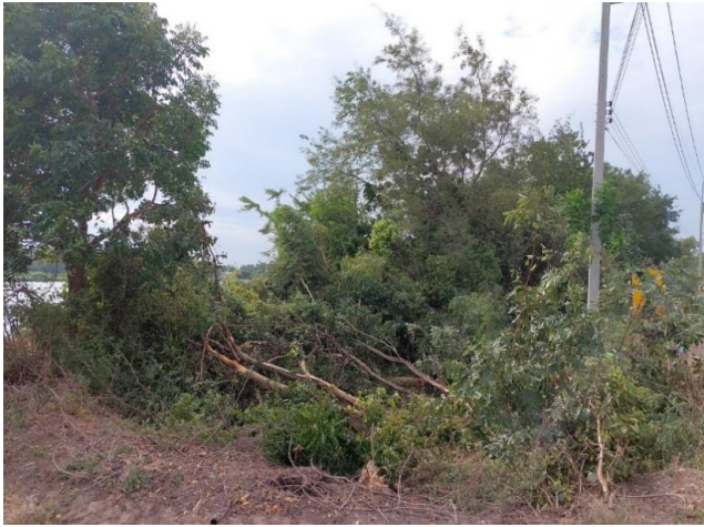
รูปก่อนการก่อสร้าง กม.ที่ ๑๕+๐๐๐
