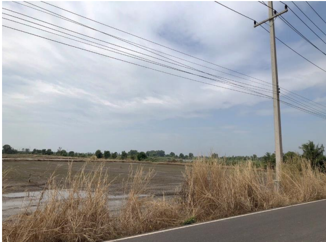
รูปก่อนการก่อสร้าง กม.ที่ ๑๘+๘๐๐
