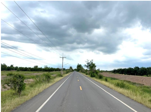
รูปก่อนการก่อสร้าง กม.ที่ ๑๓+๙๐๐
