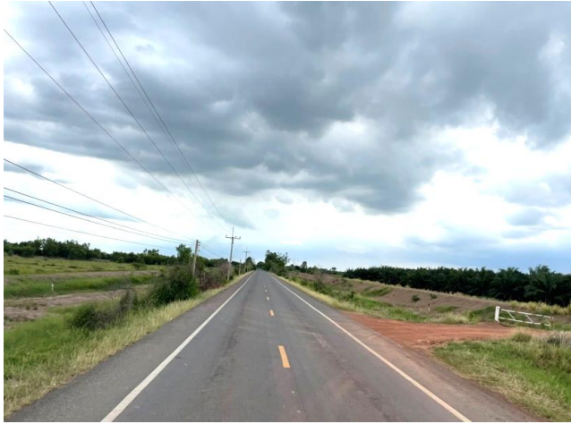
รูปก่อนการก่อสร้าง กม.ที่ ๑๓+๘๐๐
