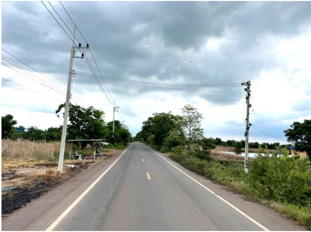
รูปก่อนการก่อสร้าง กม.ที่ ๑๔+๔๐๐
