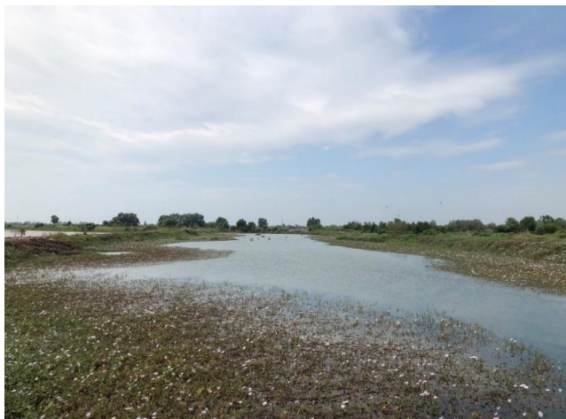
รูปก่อนการก่อสร้าง กม.ที่ ๑๘+๙๐๐
