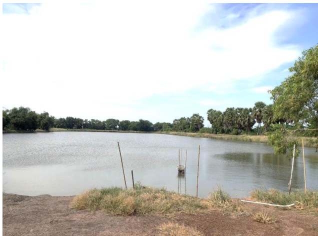
รูปก่อนการก่อสร้าง กม.ที่ ๑๗+๘๐๐
