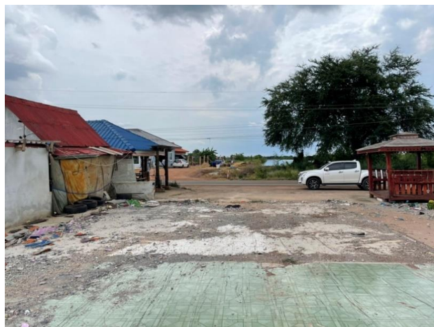
รูปก่อนการก่อสร้าง กม.ที่ ๑๕+๓๐๐
