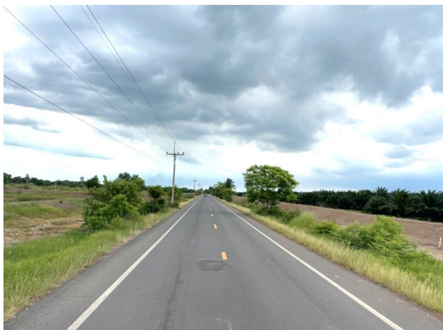
รูปก่อนการก่อสร้าง กม.ที่ ๑๓+๕๐๐
